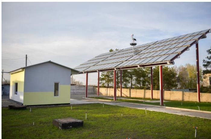
На территории котельной «Орто-Сай» размещено 120 панелей мощностью по 1,4 кВт-час, общая мощность комплекса – 0,168 МВт или 0,144 Гкал/час. Максимальная рабочая температура 90-120 градусов С.
